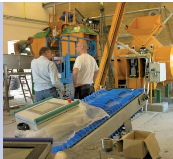
Travlhed med installation og klargøring af den nye prøvevask
